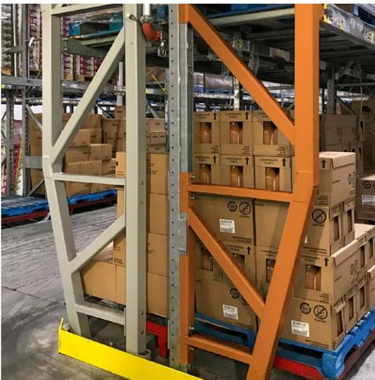
Le DAMO PRO CAN répare les dommages aux colonnes avant et arrière d'une échelle de palettier.
